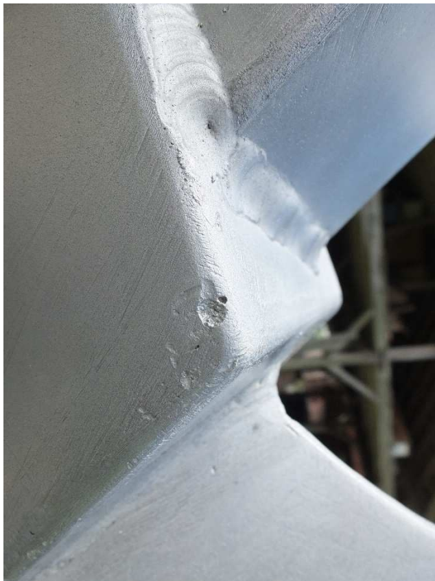
Die gleiche Stelle nach der Restaurierung
